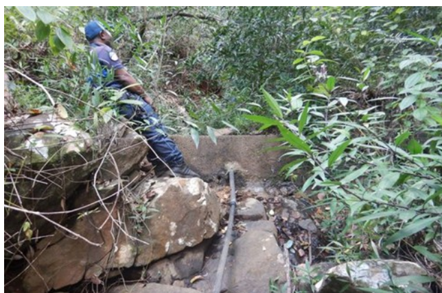
Ouvrage avant démolition...
