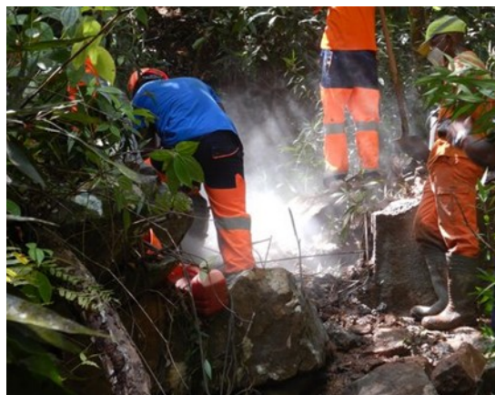
... et en cours de démolition
